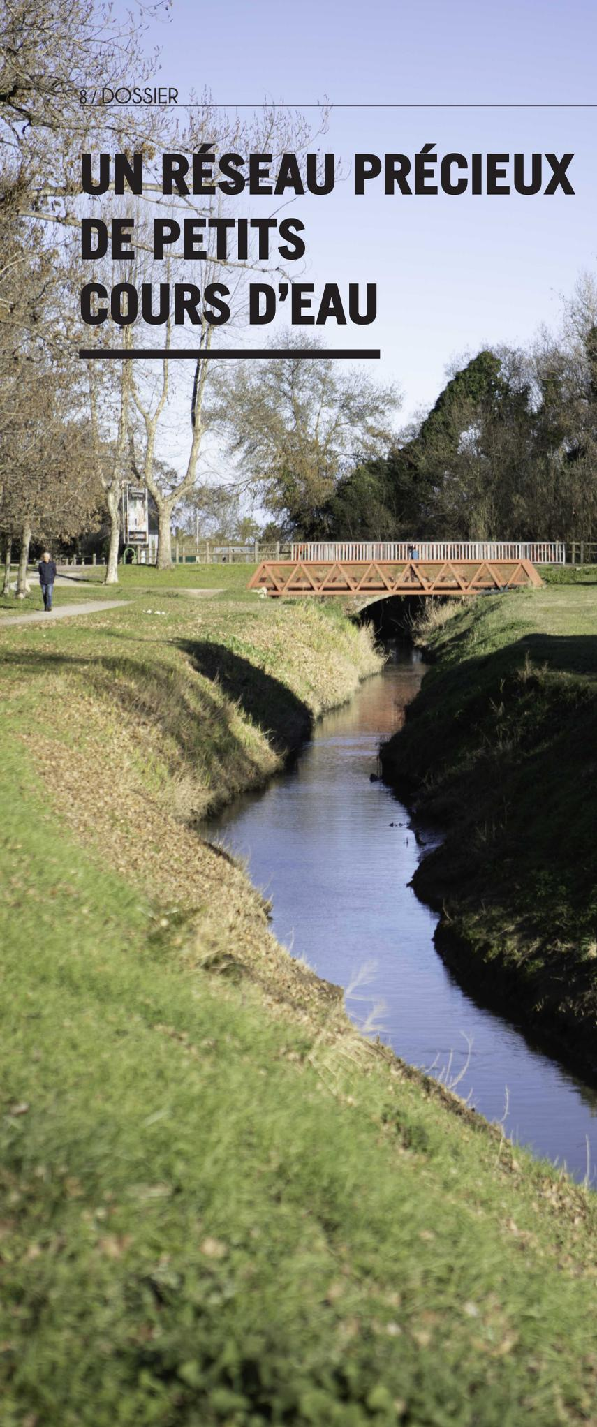
Construits au XII<sup>e</sup> siècle pour assainir les marécages et rendre les terres de la commune cultivables, les canaux de Saint-Cyprien traversent la ville de part en part. D'une longueur totale de 38 km (32 km de canaux en terre ou bétonnés, 5 km d'agouilles et 1 km d'entrée de canal busé), ils ont pour fonction d'acheminer les eaux de pluies jusqu'à la mer, ce qui en fait de formidables outils de lutte contre les inondations.
